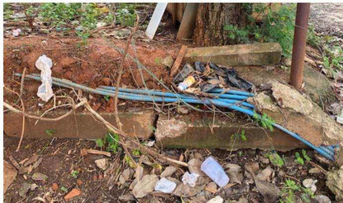
Figura 3: Infraestrutura precária das ligações coletivas propensa a vazamentos e contaminação.
